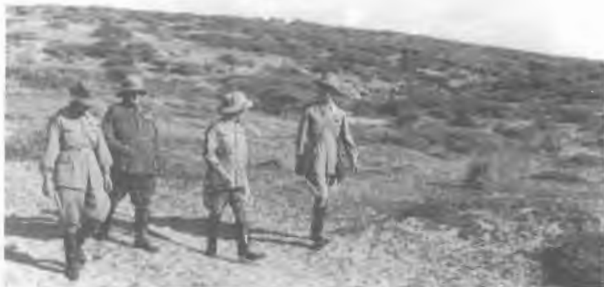
Visita di perlustrazione nella zona adiacente al campo per valutare la possibilità di costruire una camionabile
